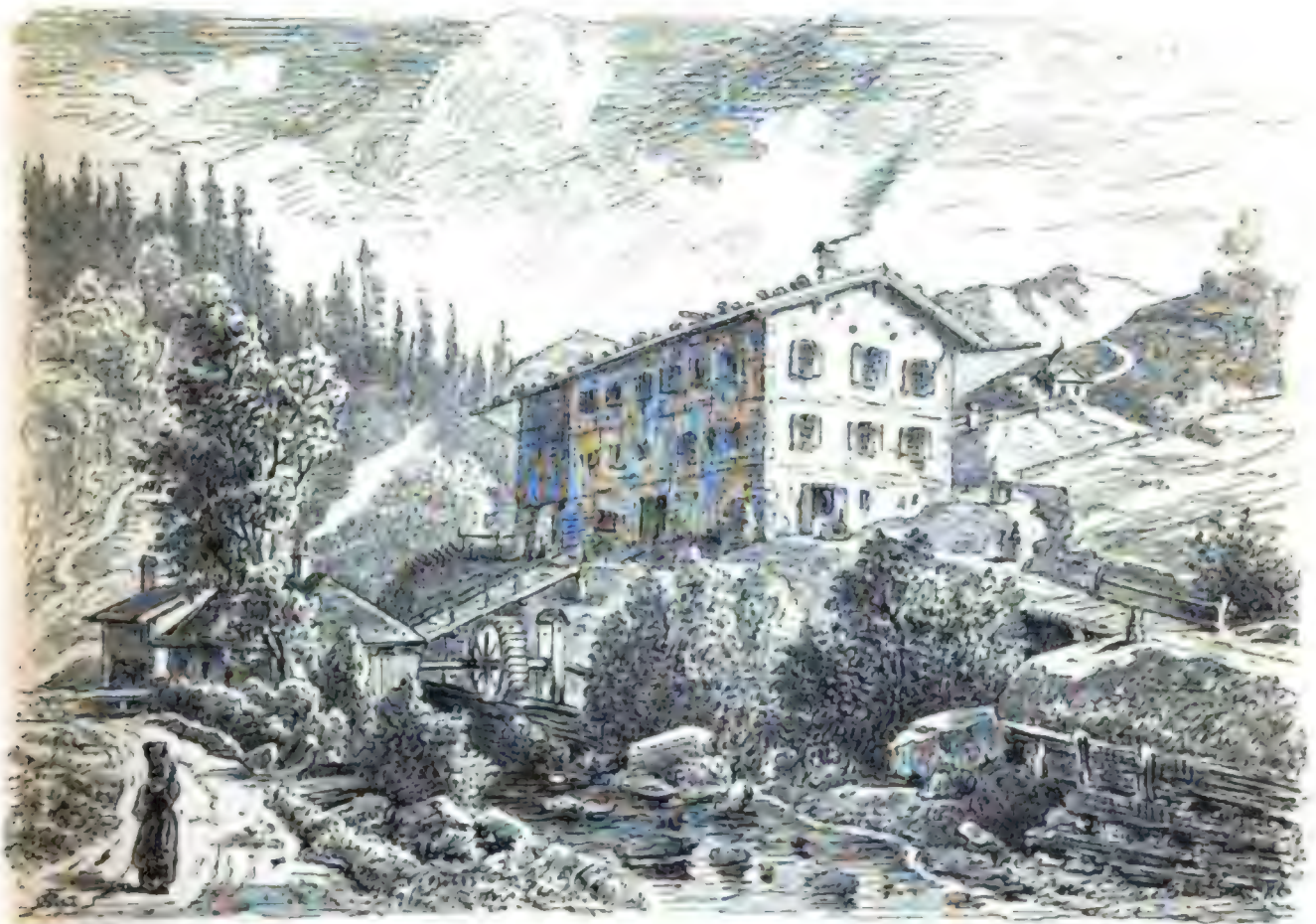
Beschwertes Dach im Allgäu.
